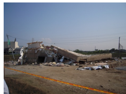
図-1 竜巻による建物の転倒被害
