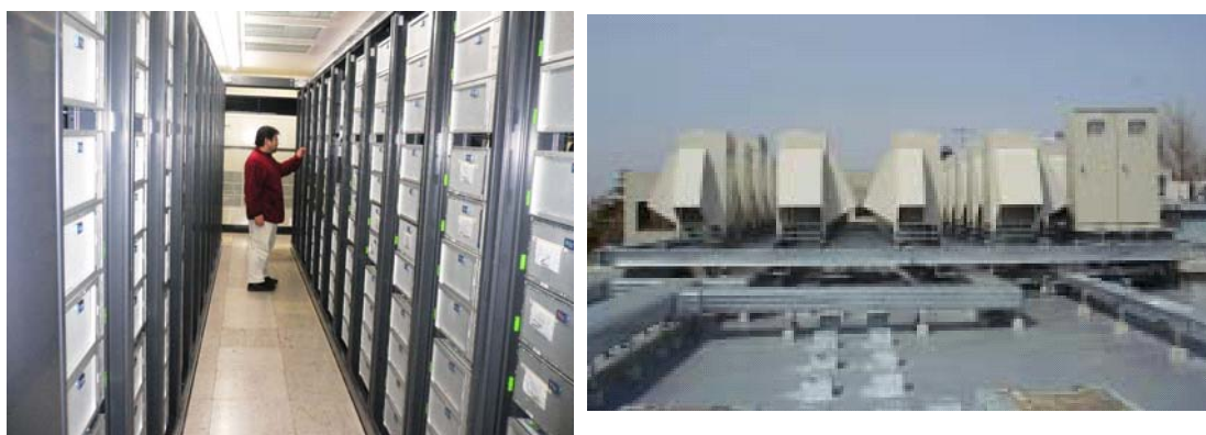
図 3 : (左)TSUBAME の一部、(右)GSIC 屋上に新設された冷房屋外装置
