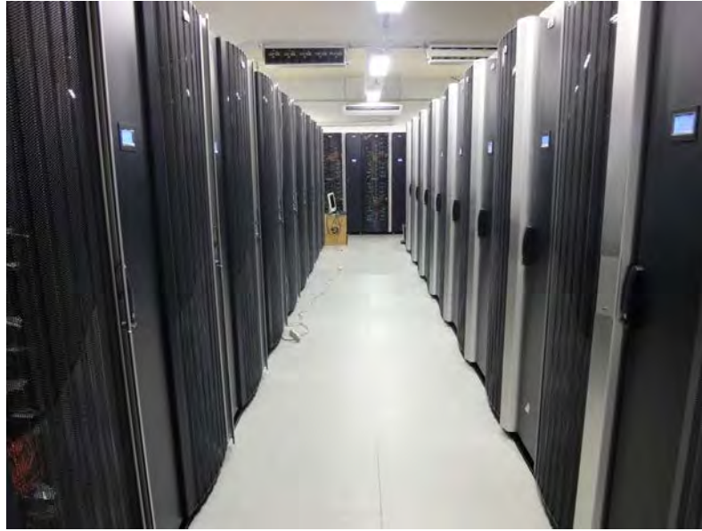
図 1: MCS ラックが並ぶ、TSUBAME2.0 計算機室の様子
