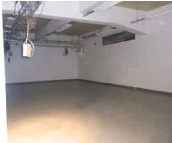
図 8: 事務室の引っ越し後、TSUBAME2.0 設置前の様子
