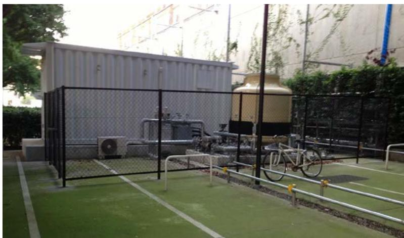
学術国際情報センター情報棟に隣接する TSUBAME-KFC システム。コンテナ型の実験設備を採用し、屋外にポンプや冷却塔を備える。
