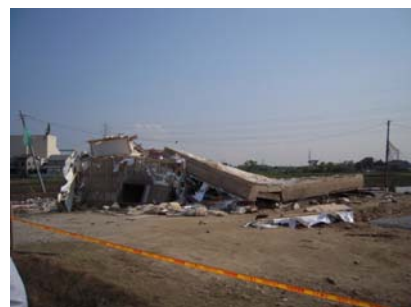
図-1 竜巻による建物の転倒被害
