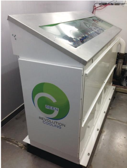
図3 コンテナ内に設置されたGRC社液浸冷却ラック(Carnot Jetシステム)。
